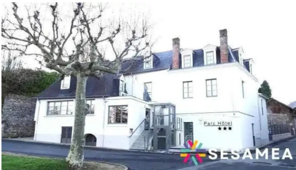
Parc hotel pompadour arnac pompadour
